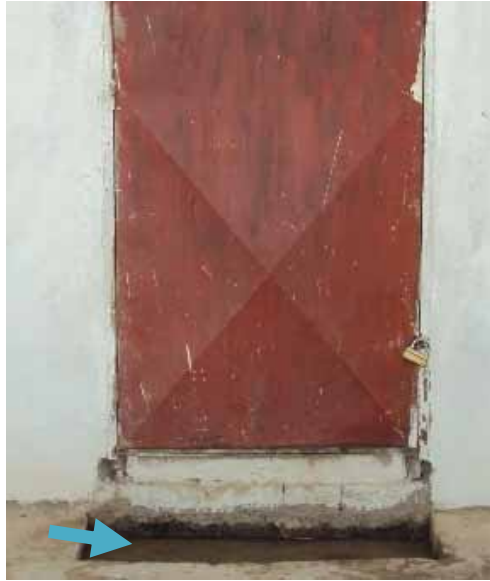
Figure 6 : Porte fermée à clé avec présence d'un pédiluve fonctionnel
