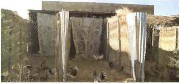
Photo 3 : Hangar vu du côté nord Cliché Yoda
