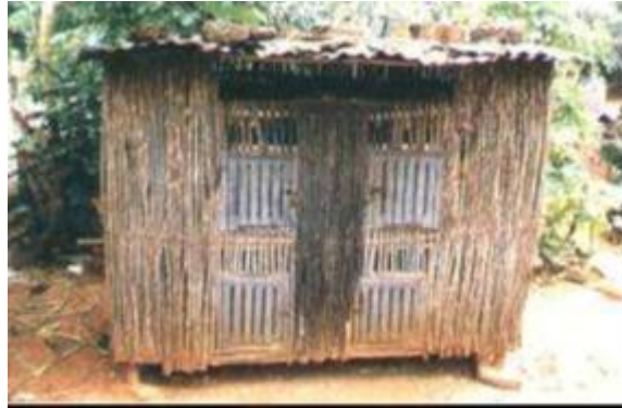
Figure 3 : Unités de case recouverte d'un toit en tôle
